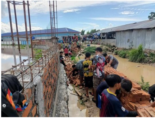
学生们在修防洪墙
